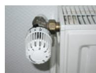
**Thermostatventile** sollen eine eingestellte Raumtemperatur halten. Das Ventil öffnet, wenn die Einstellung unterschritten wird - das
